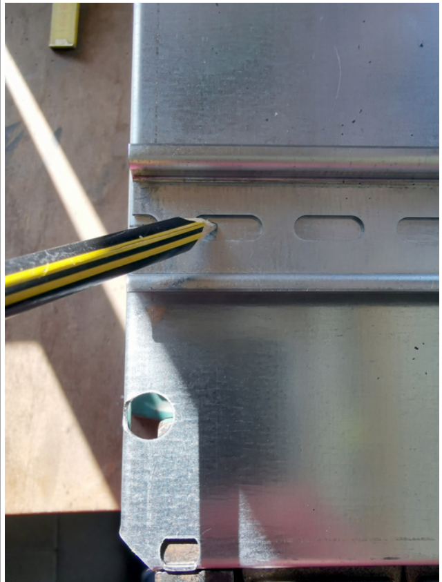
Bild 5: Hutschienen fertig installiert
