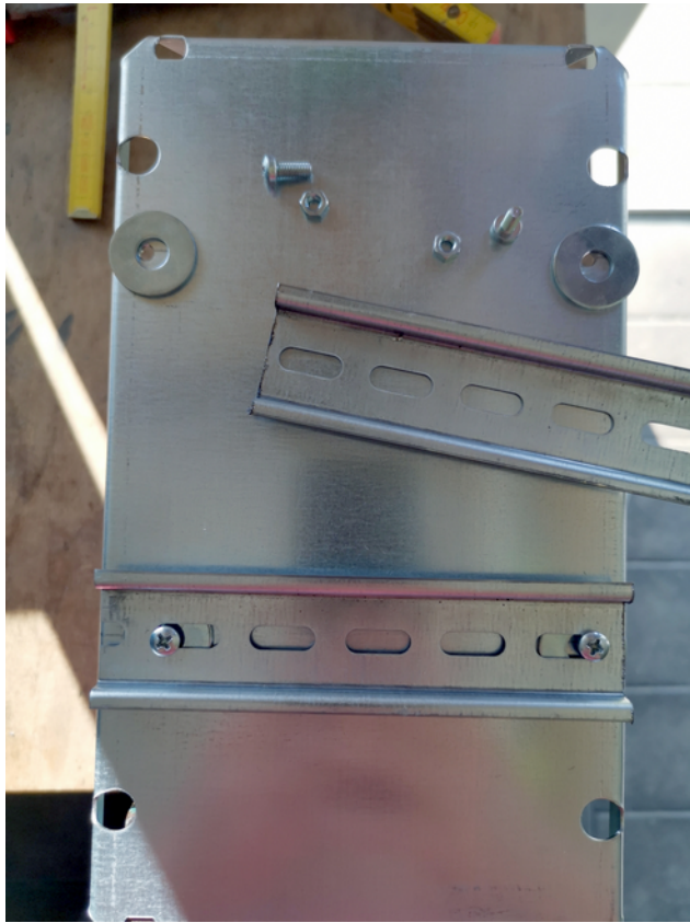
BILD 5: Hutschienen verschrauben
